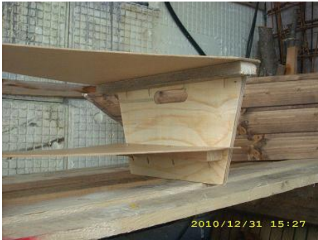
Abb. 4: Verschraubung der Hartfaserplatten
