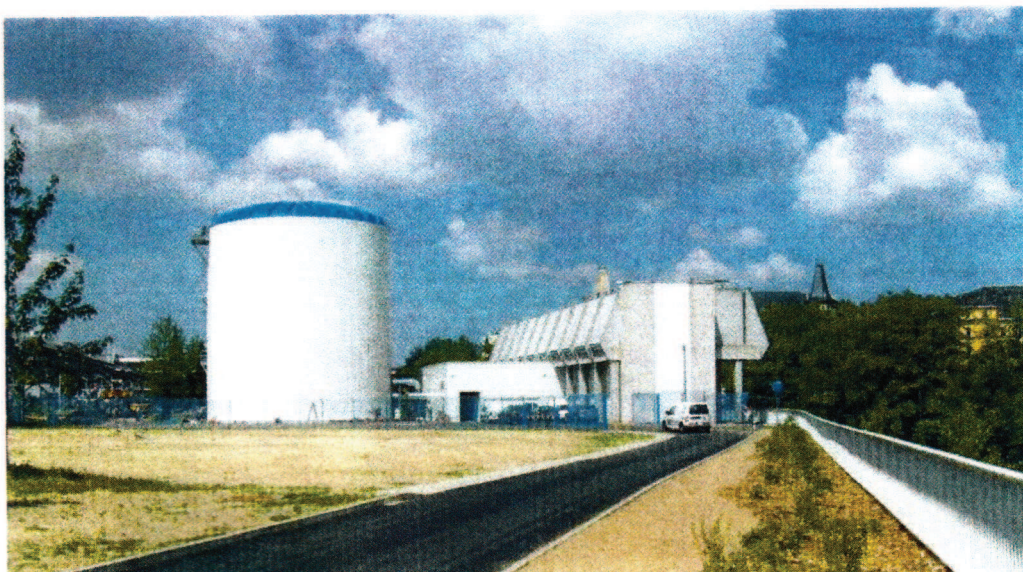
Der Kältespeicher an der Georgstraße
