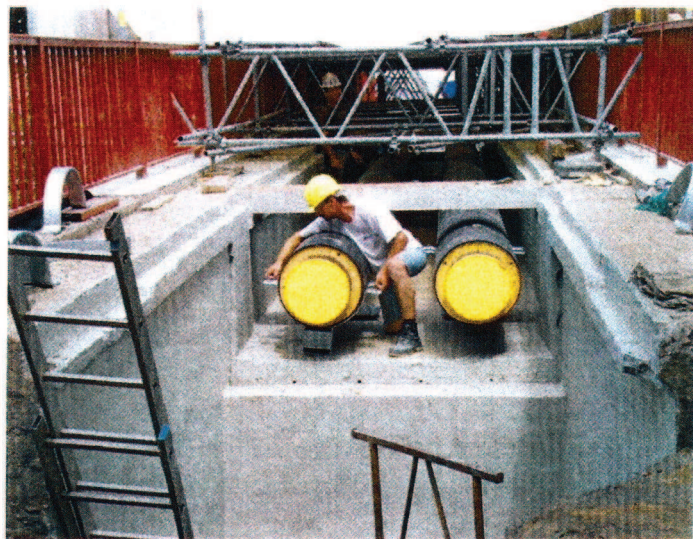
Netzanpassung Fernwärme für Neubau der Hartmannbrücke
